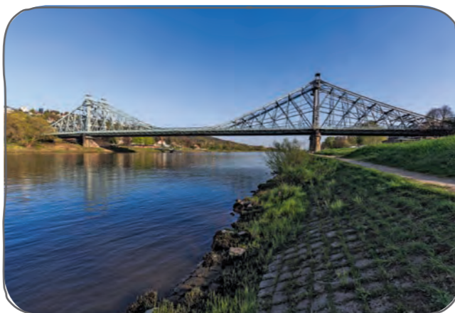
Das Blaue Wunder war eine der ersten Flussbrücken ohne einen einzigen Pfeiler im Wasser.
